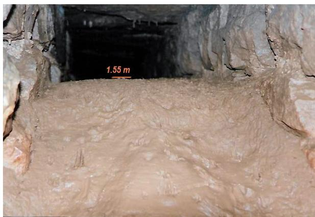
*Epaisseur du dépôt d'argile dans un des aqueduc (photo ARN)*
