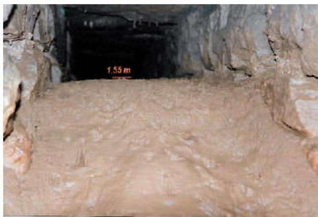
*Épaisseur du dépôt d'argile dans un des aqueduc (photo ARN)*
