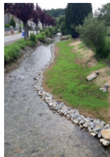
Ruisseau des Roises à Greux- Travaux de réalisation des banquettes végétalisées- juillet 2024
